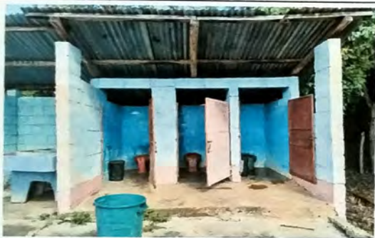
Foto 7: MODULO A SERVICIOS SANITARIOS Vista Frontal de modulo de servicios sanitarios
