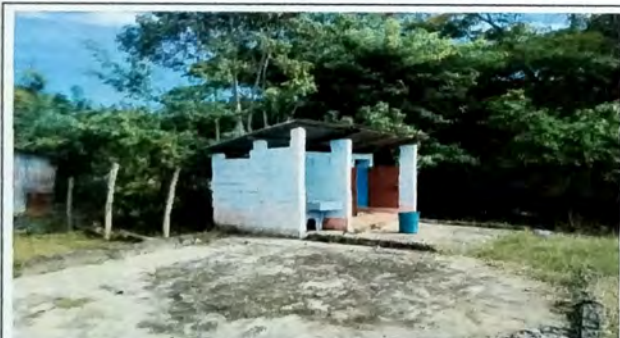
Foto 3: MODULO A Servicios Sanitarios, cambio de puertas de metal en mal estado, levantado de muro al contorno de muros existentes, sustitucion de sanitarios de concreto. Se colocara piso ceramico
