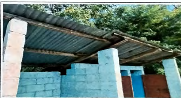
Foto 4: MODULO A Sustitucion de estructura de madera y lamina de zinc en mal estado, sustitucion de sanitario de concreto en mal estado. Se ampliara area techada frente a modulo.
