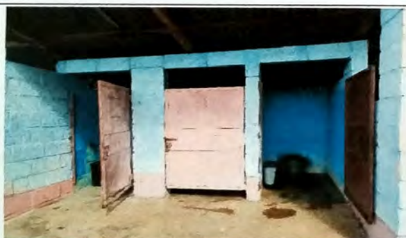
Foto 9: MODULO A Servicios Sanitarios, cambio de puertas de metal en mal estado, levantado de muro al contorno de muros existentes, sustitucion de sanitarios de concreto. Se colocara piso ceramico
