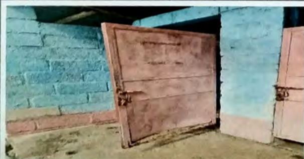
Foto 5: MODULO A Sustitucion de puertas de metal en malas condiciones, Modulo de Cocina actual no es comoda para la actividad de cocimiento, muy pequeña y poca ventilacion se sustituirá por una nueva
